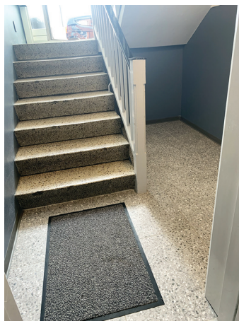
Nye fliser i bunden af trappeopgangen
